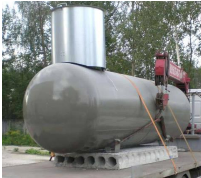
Рисунок 2. Ошибка в выборе основания под газгольдер
