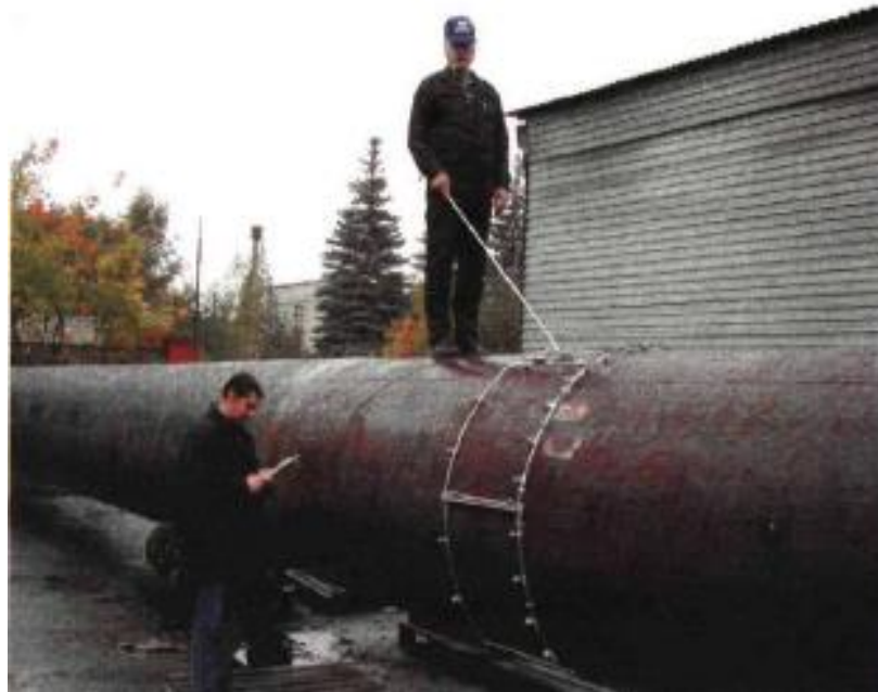
Рисунок 3. Общий вид сканирующего устройства с обхватом всего периметра трубы Д1420 мм с использованием приборно-компьютерного комплекса по методу магнитной памяти металла
