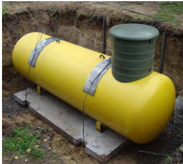
Рисунок 5. Ошибка в креплении газгольдера к основанию
